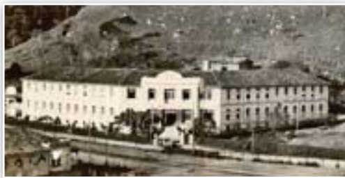
Hotel San Pablo, en Águas da Prata
